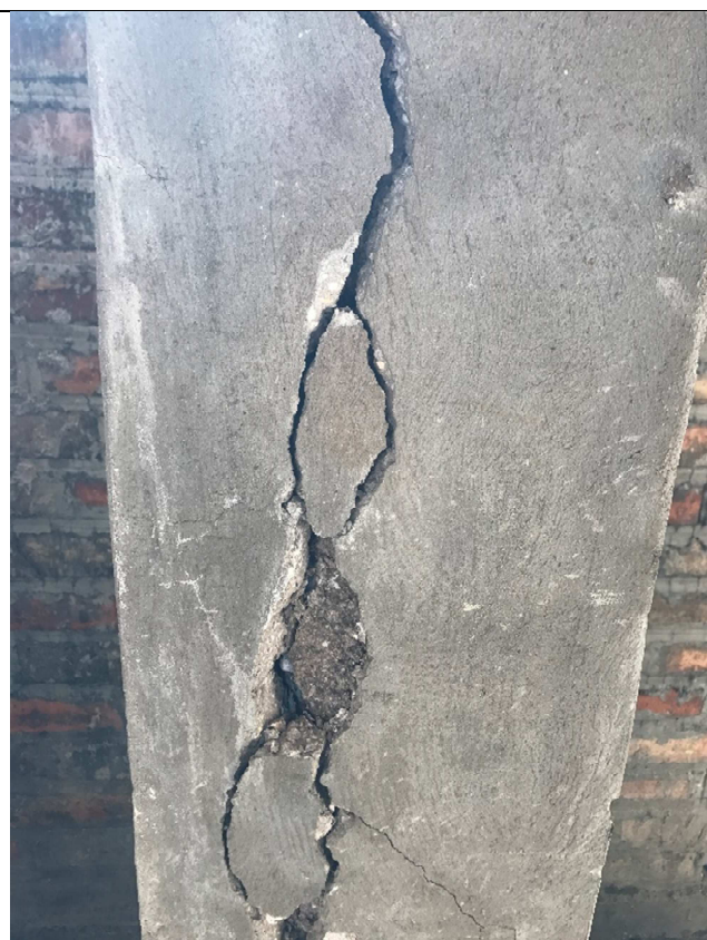
Particolare lesioni del pilastro
