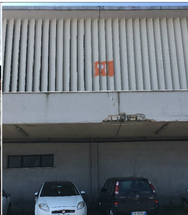
Particolare giunto strutturale vista frontale
