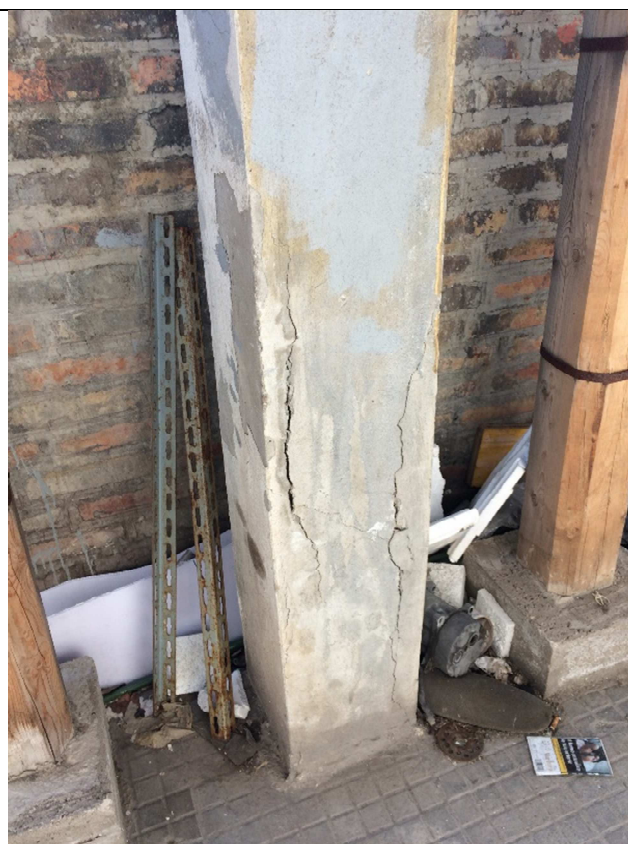
Particolare lesioni del pilastro
