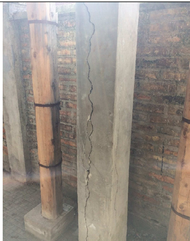
Particolare lesioni del pilastro
