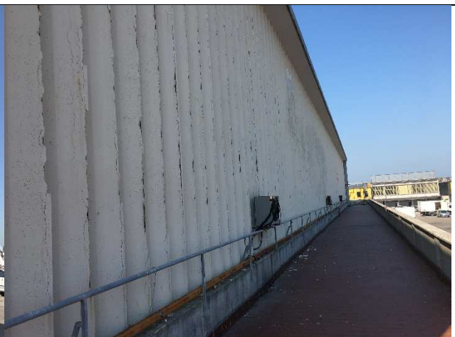
Stato di degrado dei frangisole
