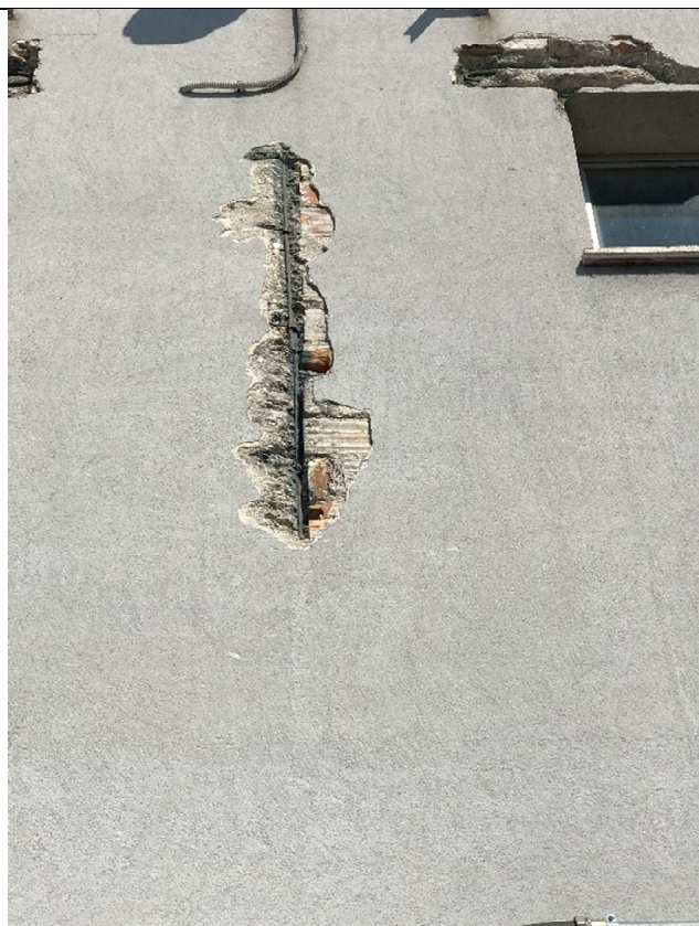
Tracce degli interventi precedenti di passivazione dei ferri non ripristinati
