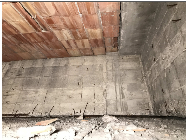
Vista frontale della trave longitudinale in corrispondenza del giunto sul solaio di plafonatura
