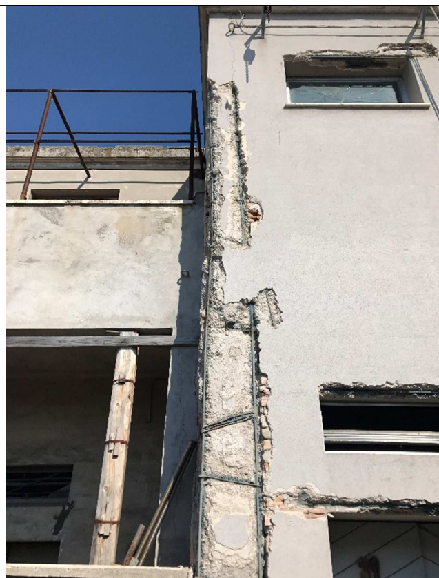
Assenza di armature trasversali nella parte alta dei pilastri posteriori
