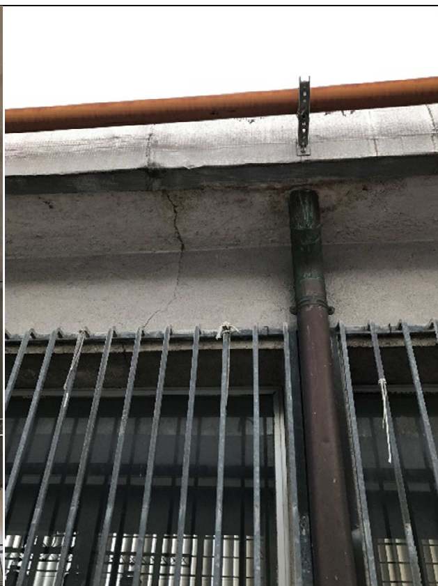
Lesioni sulla parete del volume interno sul lato del ballatoio 1
