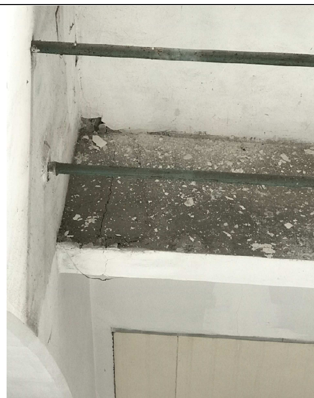
Lesioni sulla parete del volume interno sul lato del ballatoio 1
