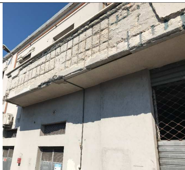
Tracce degli interventi di passivazione dei ferri
