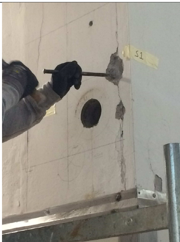
Dettaglio scasso pilastro 21
