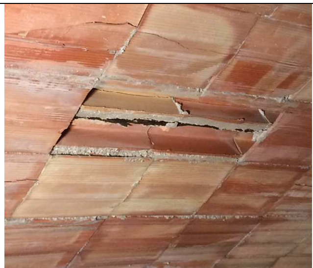
Intradosso del solaio SAP da 12 cm
