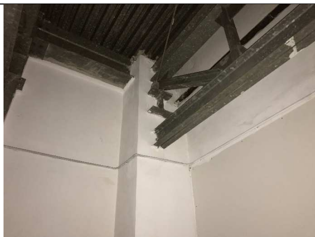
Particolare collegamento trave reticolare-pilastro
