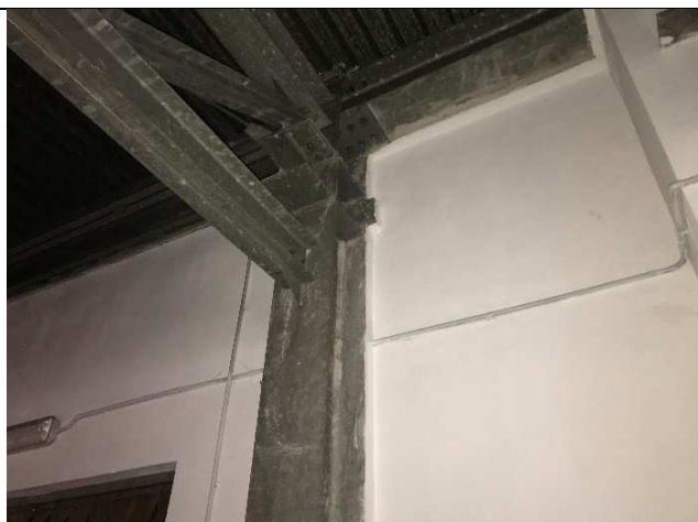
Particolare collegamento trave reticolare-pilastro
