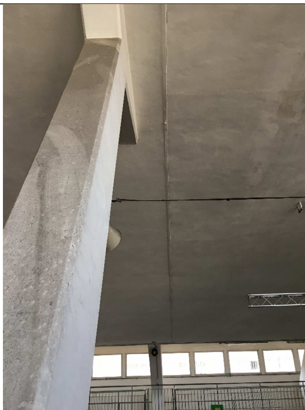
Particolare giunto intradosso solaio di plafonatura di spessore 2,5 cm
