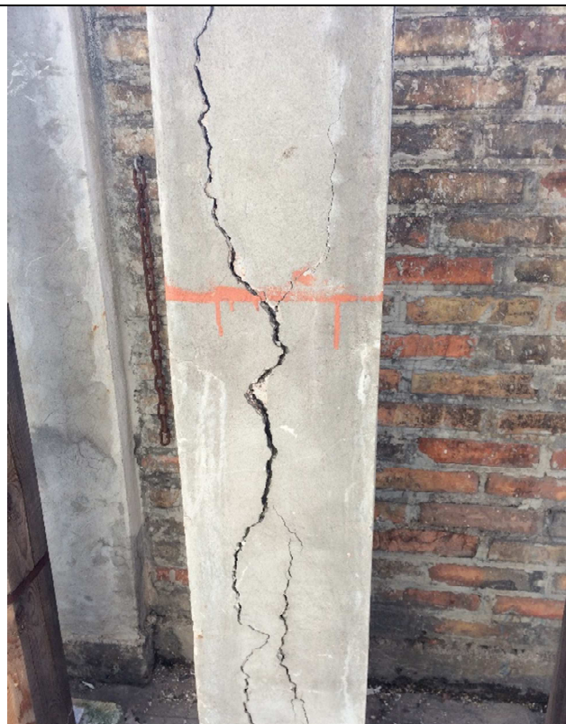
Particolare lesioni del pilastro
