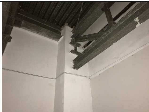
Particolare attacco reticolare del corpo A2
